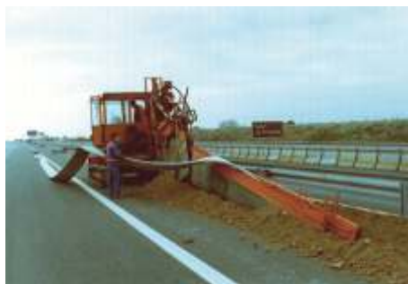
Rys. 33. Instalowanie kompozytu drenażowego jako odwodnienia podłużnego drogi.
